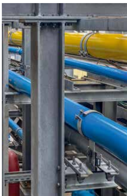
Bild: Schultheis Stahlbau
