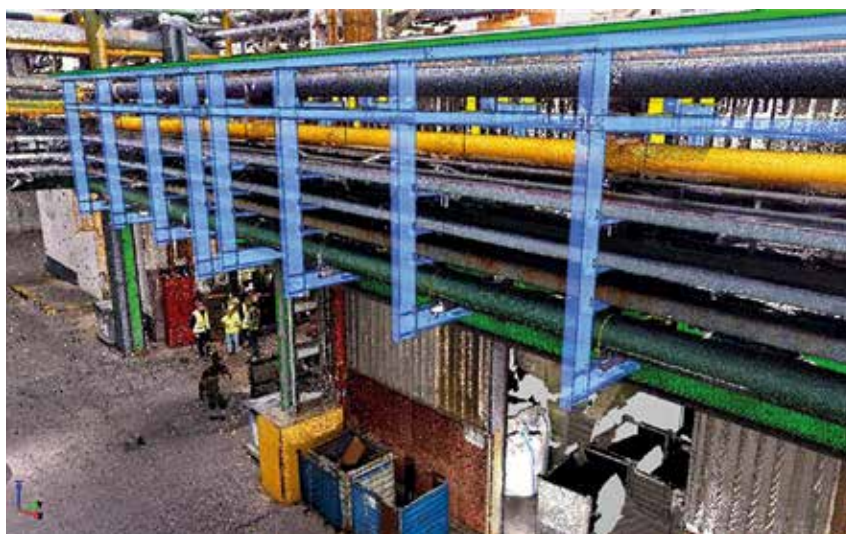
Bild: Schultheis Stahlbau
