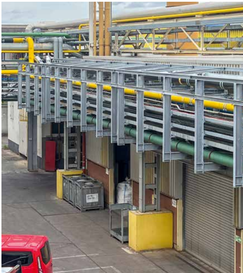
Bild: Schultheis Stahlbau
